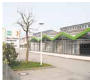
Im ehemaligen BayWa-Baumarkt an der Bahnhofstraße in Aichach entsteht demnächst ein kleines Sozialzentrum der Caritas. Foto: Christian Lichtenstern
